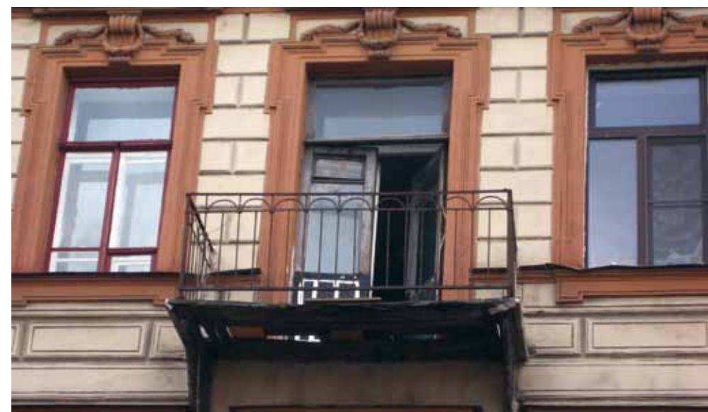
Аварийный балкон на 5-й линии ВО, дом 30
