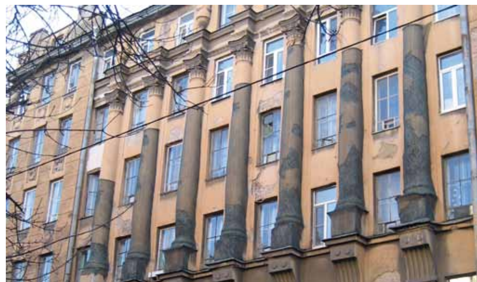
Аварийный фасад на 15-й линии ВО, дом 34
